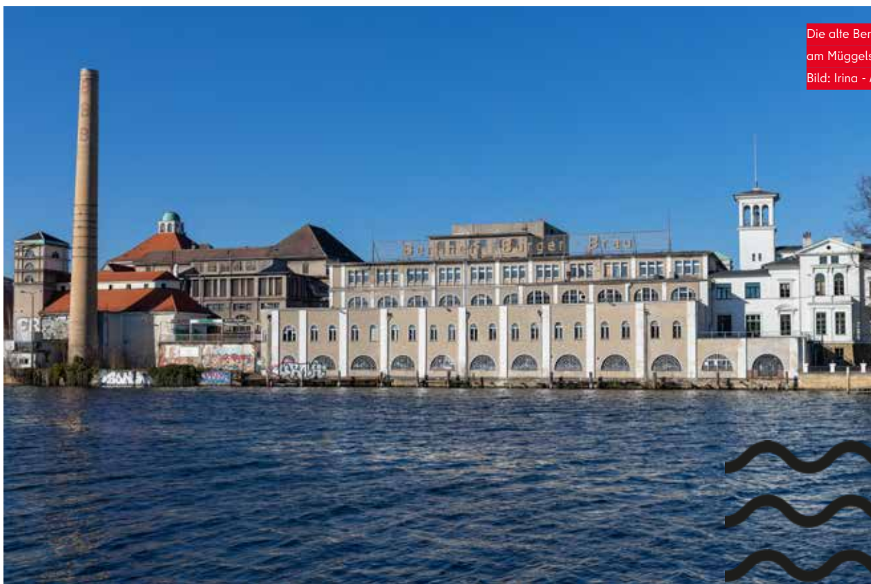
Das Wasserwerk in Friedrichshagen Bild: Berliner Unterwelten e.V./ Frieder Salm
