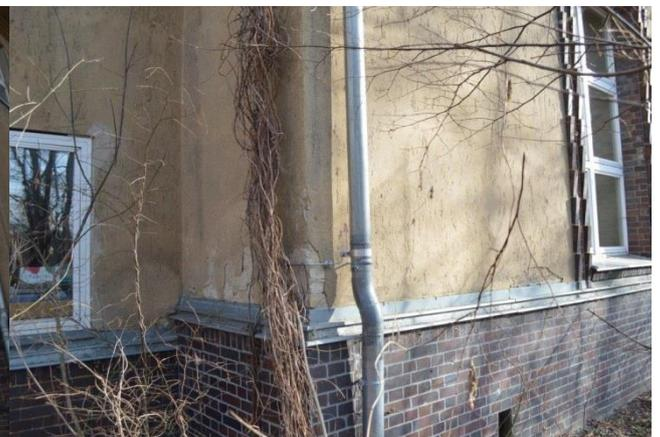
Mangelhafter Fensteranschluss sowie Schäden am Putz
