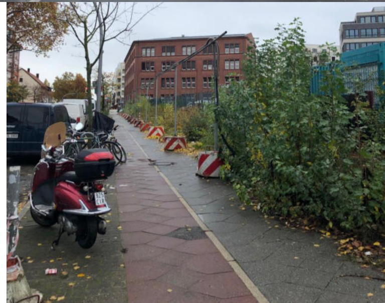
Gehweg Gotenstraße, Zustand 2020
