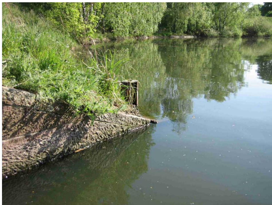
Abb. 11: Ansicht Auslaufbauwerk am 26.4.2007
