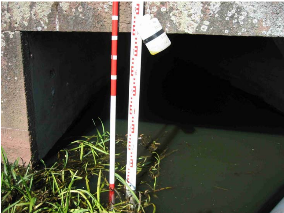
Abb. 9 Wasserstand im Auslaufbauwerk Nahmitzer Damm / Motzener Straße am 26.4.2007
