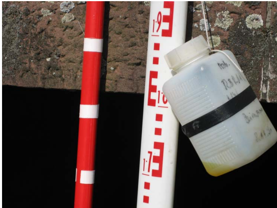
Abb. 10: Abstand Sohle zu Mauerunterkante im Auslaufbauwerk Nahmitzer Damm / Motzener Straße am 26.4.2007
