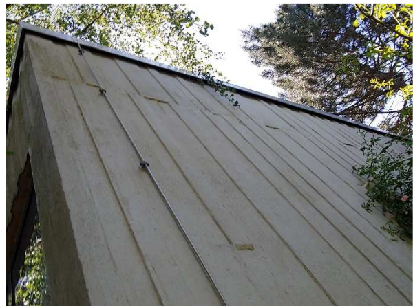
Abbildung 14: Attikablech mit Quartierpotential für Fledermäuse
