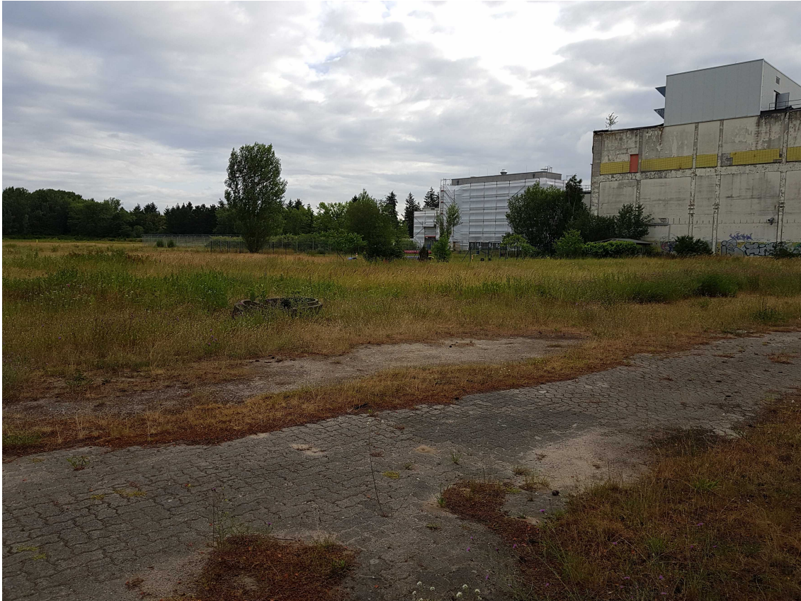
Abb. 4: Gebäude der Berliner Wasserwerke im UG, tw. eingerüstet, Ansicht von Südwesten.
