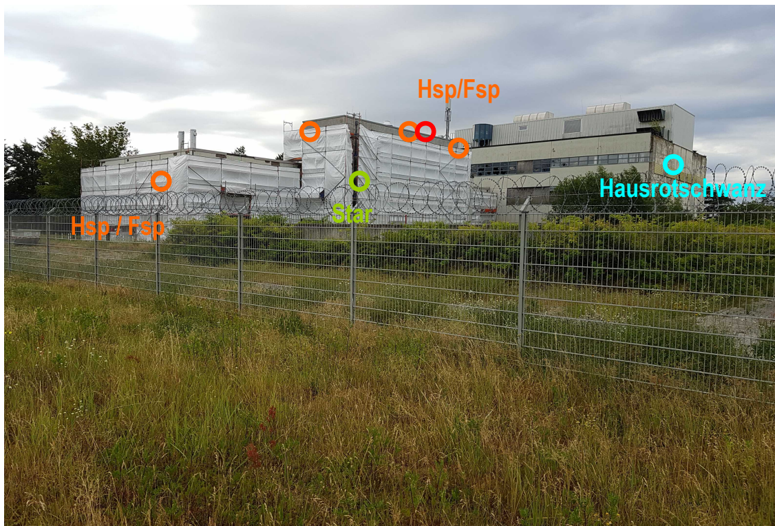
Abb. 3: Gebäude der Berliner Wasserwerke im UG, Ansicht von Nordwesten. Kreise: Vom Gerüst aus festgestellte Niststätten (weitere befanden sich auf den Gebäuderückseiten).
