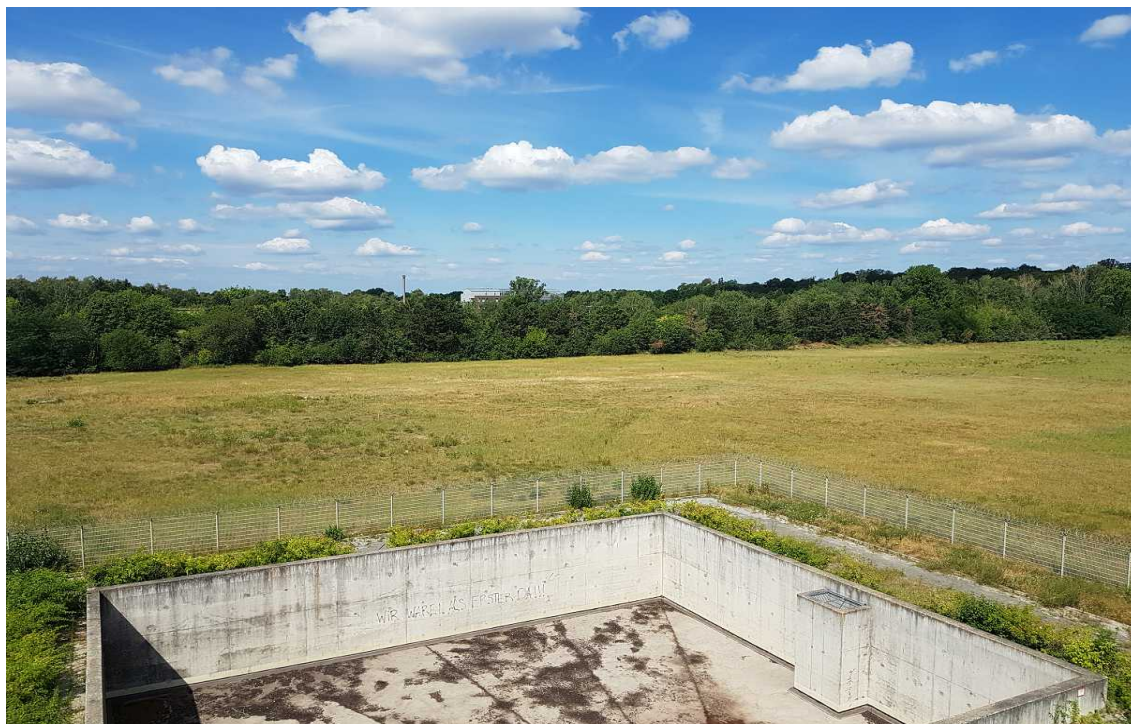
Östlicher Offenlandbereich des Wasserwerksgeländes
