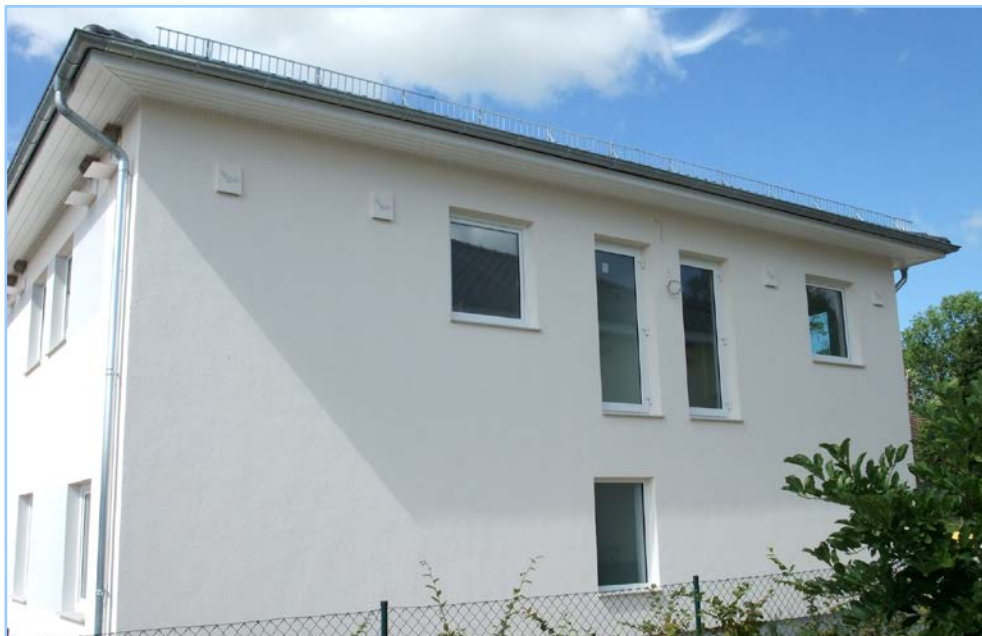
Abb. 17: Anbringung von Ersatzquartieren (Fledermauswandschalen, Mehlschwalbennester) an einem Sanierungsobjekt in Schwante, Dorfstraße 28
