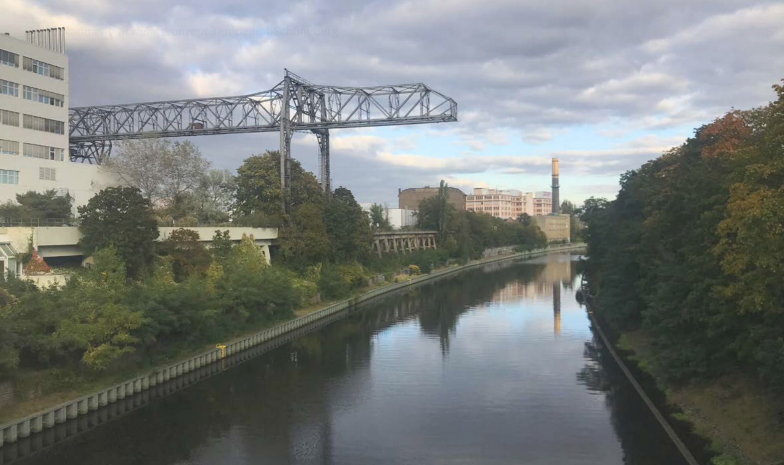
Abb. 33 Foto Teltowkanal, von Komturbrück in Richtung Osten (Foto: bgmr)
