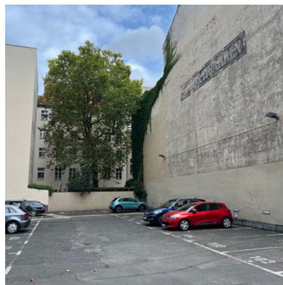
Hohe Oberflächenversiegelung, Mercator Höfe (forward)
