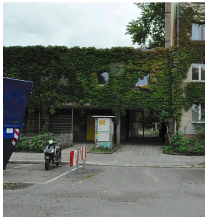
Standort Campus der Generationen (forward)
