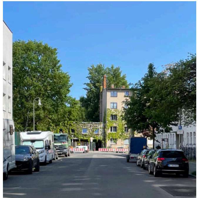
Standort Campus der Generationen (forward)
