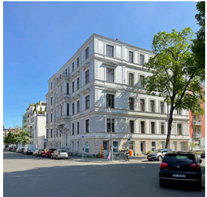
Kumi 13 (forward) – Zugang zur Halle befindet sich links neben der Eckbebauung
