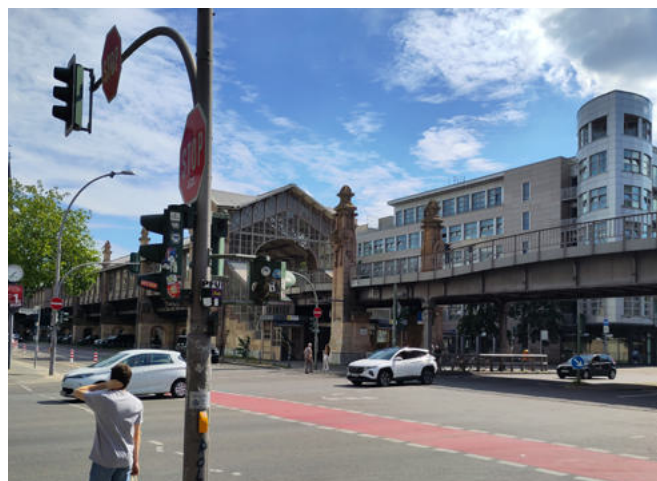
U-Bahnstation Bülowstraße (Bezirksamt Mitte)
