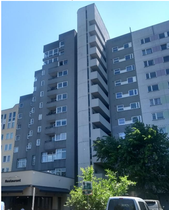
Abbildung 25: Gebäude ohne Fassadendämmung
