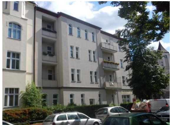
Abbildung 19: Energetisch saniertes Gebäude
