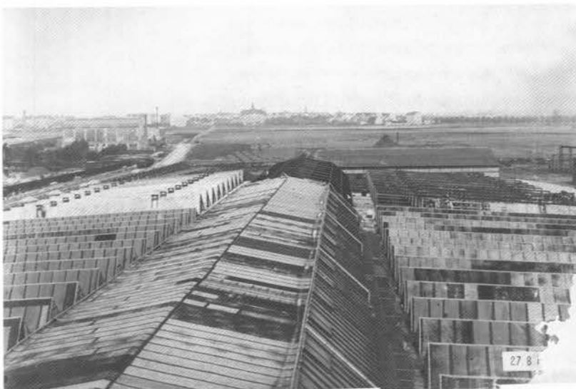
Blick nach Norden über das Dach der großen Werkhalle der Fritz-Werner AG, am linken Bildrand das Eiko-Atelier (1916)
