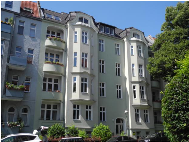
Abbildung 18: sanierte Fassade und DG-Ausbau
