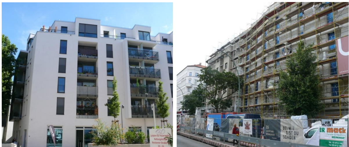
Abbildung 6: Modernisierungen und Neubau – Bautzener Straße
