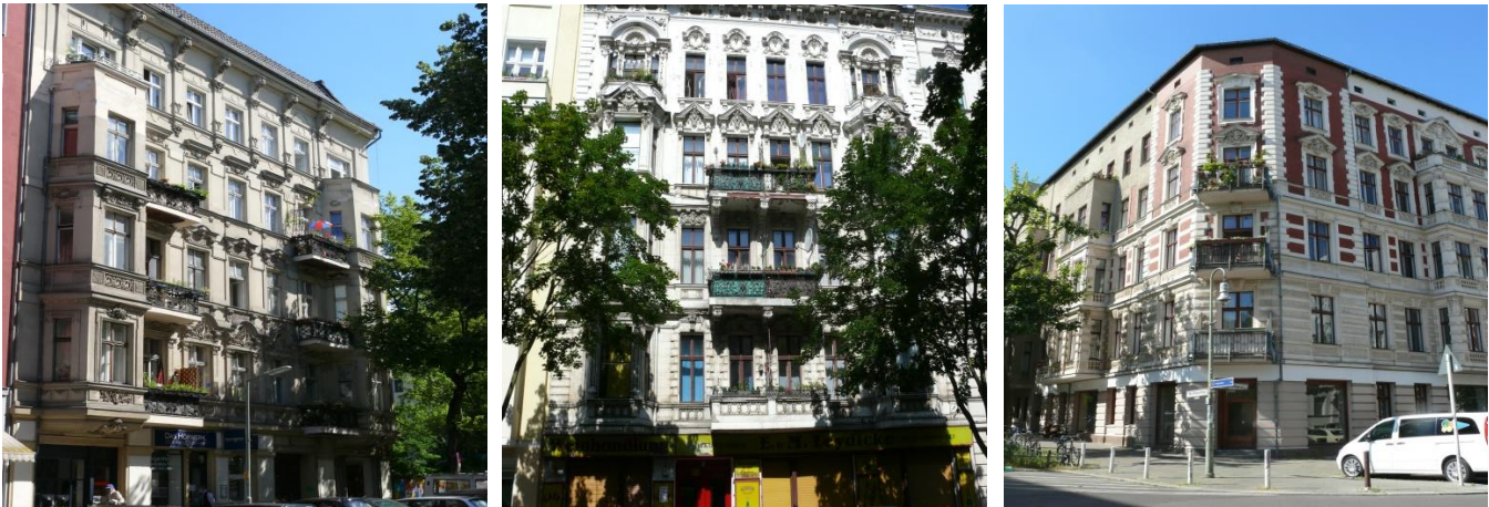
Abbildung 5: Gründerzeitliche Bausubstanz im mittleren bis guten Zustand – Bautzener Straße
