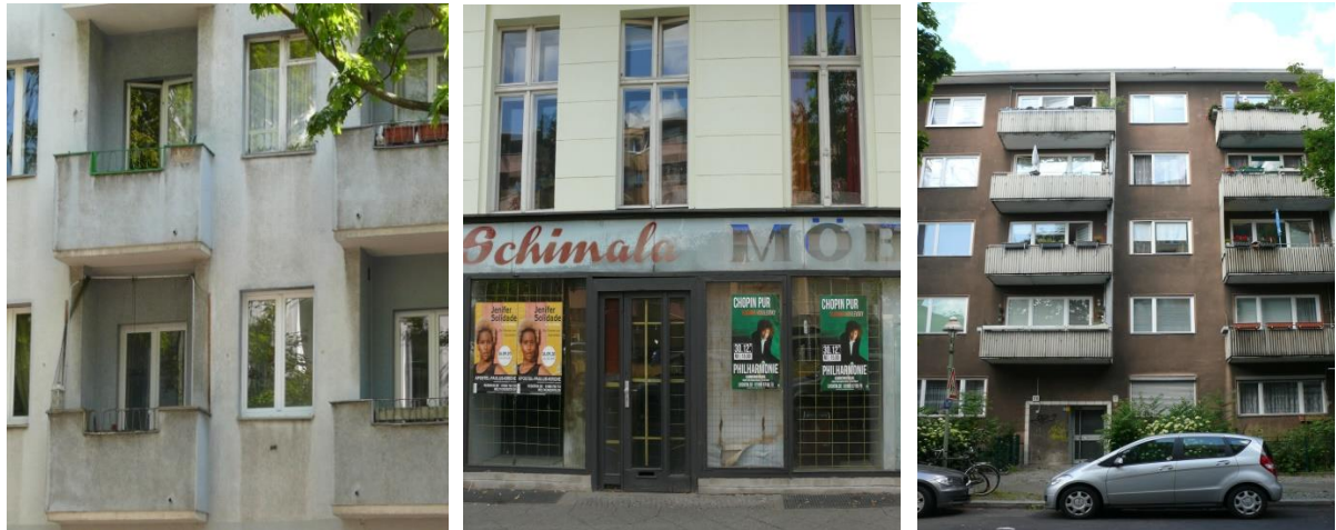
Abbildung 4: Leerstand und Altbausubstanz im schlechten baulichen Zustand – Bautzener Straße
