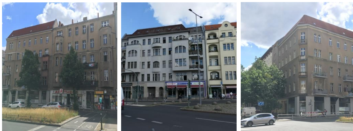
Abbildung 9: Altbausubstanz im schlechten baulichen Zustand – Kaiser-Wilhelm-Platz
