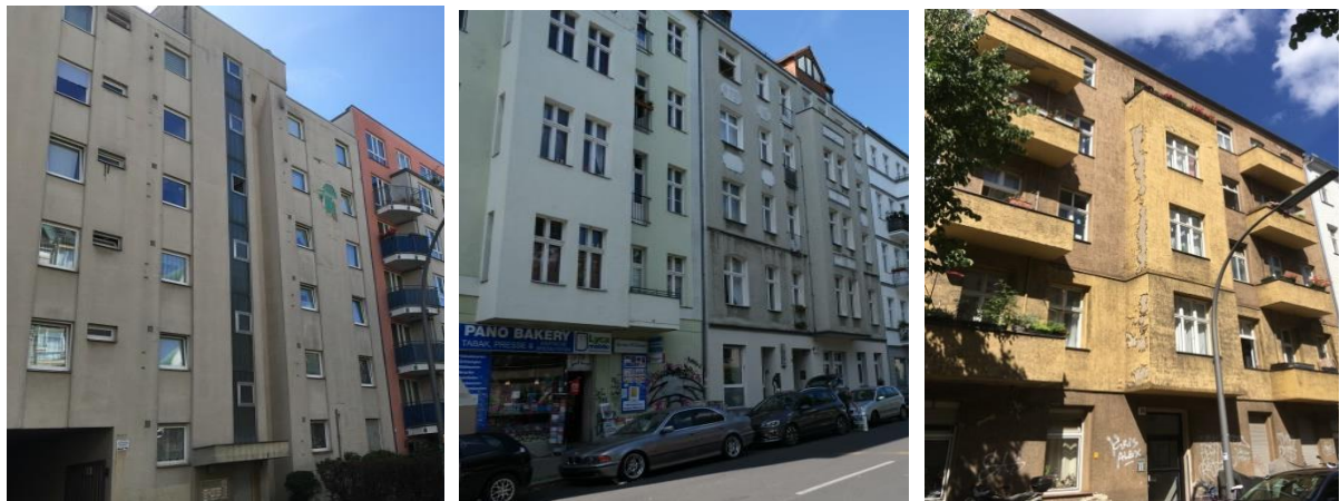
Abbildung 14: Bausubstanz im schlechten baulichen Zustand – Schöneberger Insel
