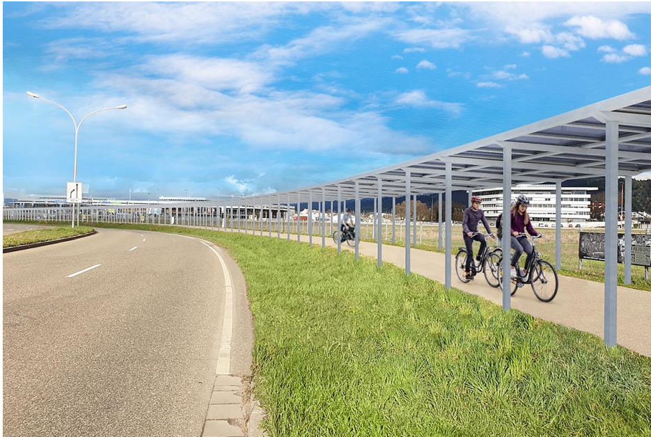
Abbildung 13: Solar-Radwegeüberdachung eines Pilot-Projektes in Freiburg
