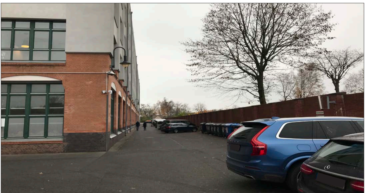
Abb. 4: GSG-Bestandsgebäude und Stellplatzfläche
