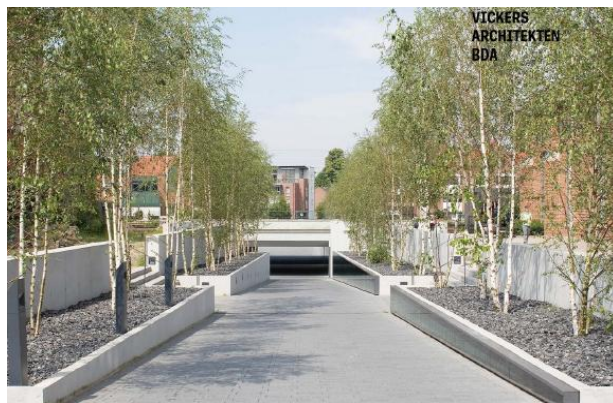
Abbildung 23: Neubau Unterführung Bahnhof Lingen, Vickers Architekten BDA
