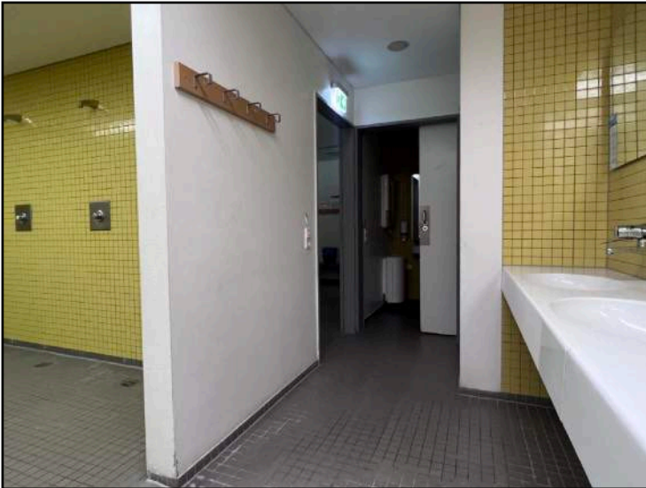
Abb. 24 (rechts): Schiebetür im Flur für zuschauende Gäste (allgemein keine Unfallgefahr durch aufgehende Tür)
