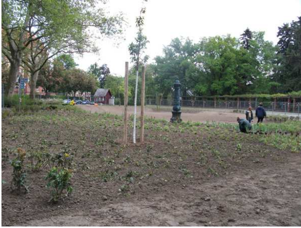
Pflanzenarbeiten auf dem neugestalteten Jürgen-Fuchs-Platz, Königin-Luise-Straße, 2011
