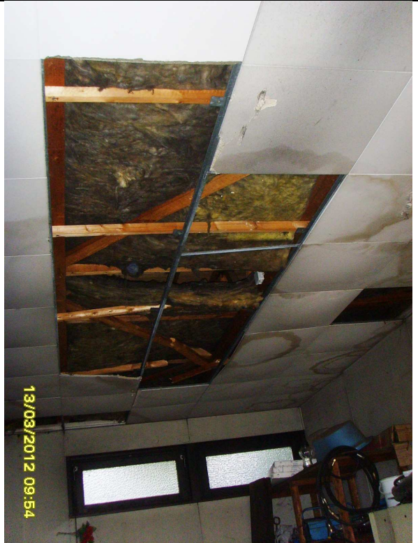
Garage Friedhof Onkel-Tom-Straße
