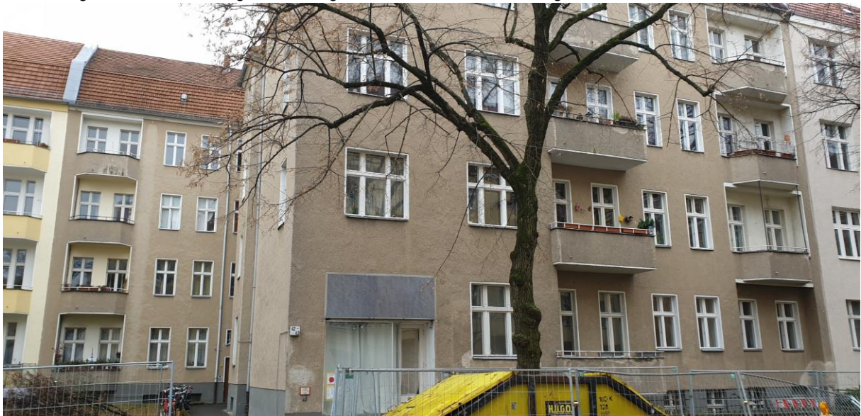
Abbildung 31: Vorbereitung des Dachgeschossausbaus und Aufzugsanbaus in der Markelstraße
