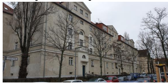
Abbildung 13: Wohnungsbau der 1920er Jahre
