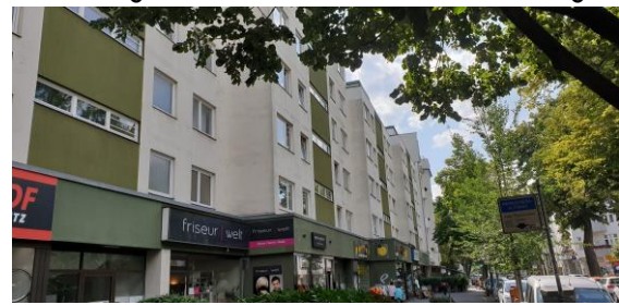
Abbildung 12: Gebäude aus der Nachkriegszeit
