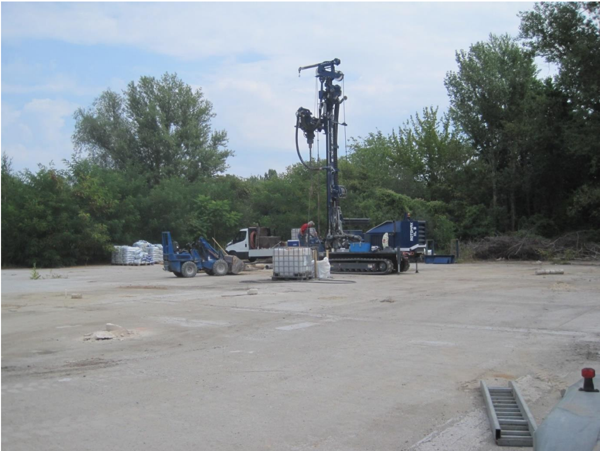
Abbildung 4: Betonfläche innerhalb der BBK-Fläche 9654 während der Bohrarbeiten.
