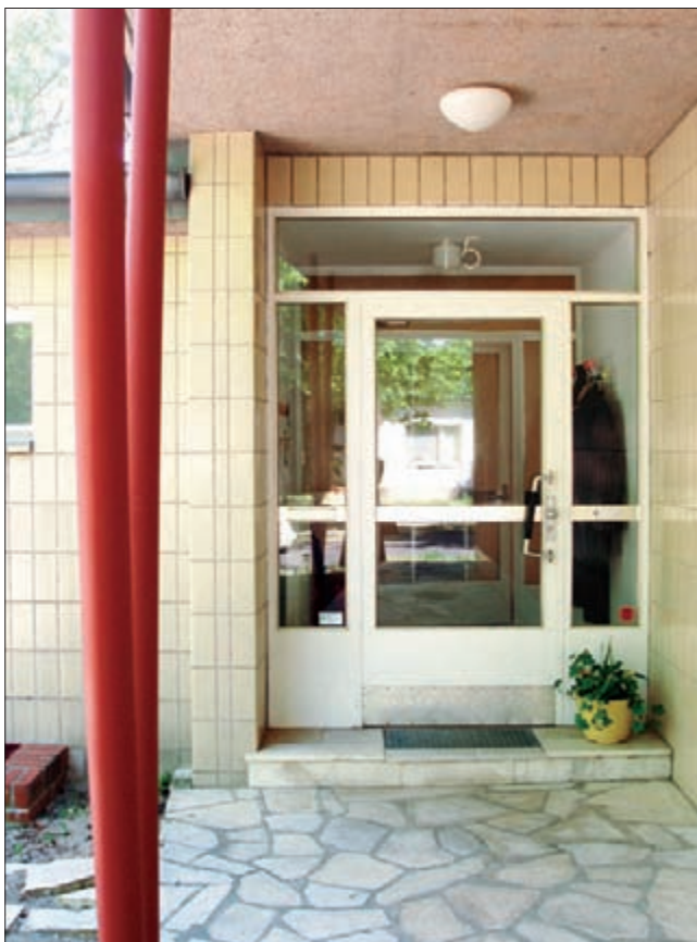
Bungalow: Haustür in bauzeitlicher Farbigkeit
