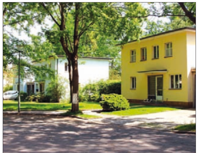
Duplex-Häuser: Vorgärten ohne Einfriedung
