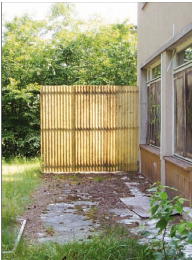
Duplex-Haus: Bauzeitlicher Windfang
