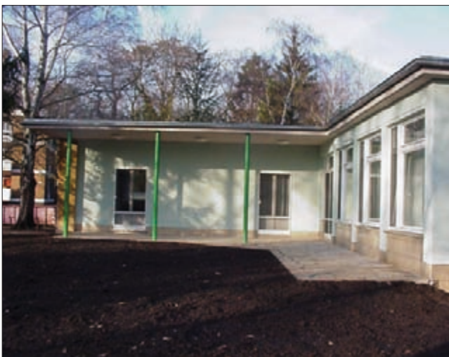
Bungalow: Rückfront nach Sanierung (vor Rasenaussaat)
