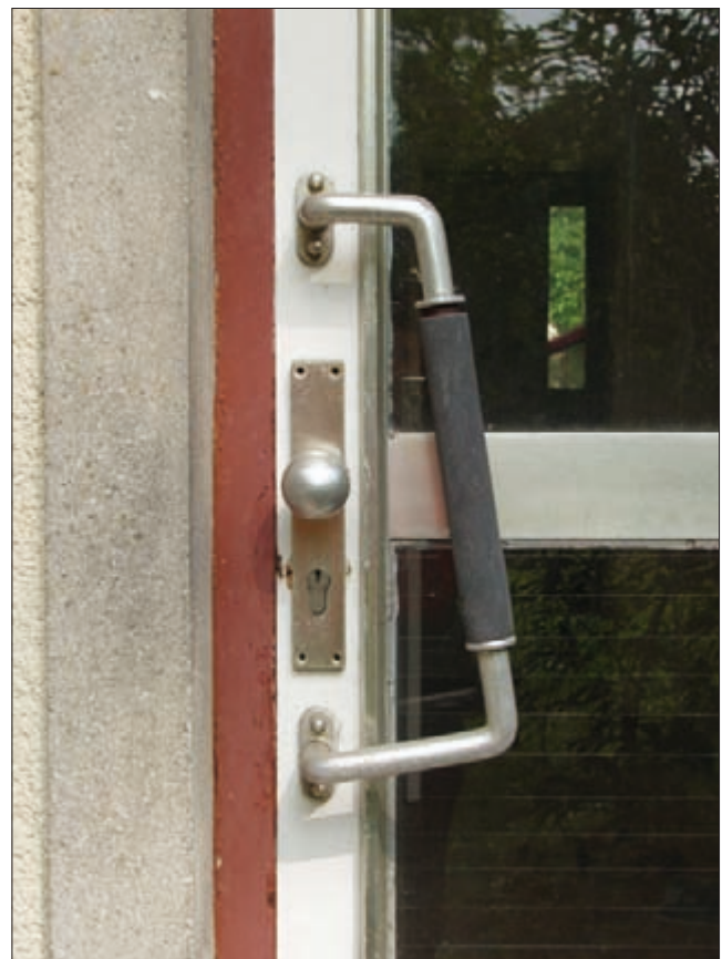
Duplex-Haus: bauzeitlicher Türgriff und Schlagleiste in originaler Farbigkeit
