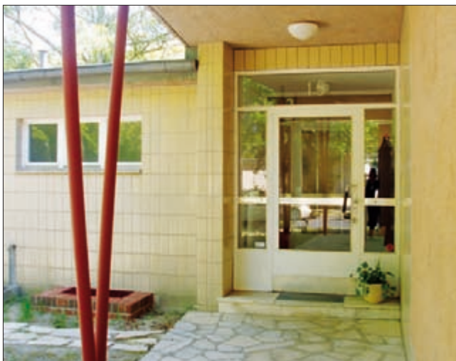
Bungalow: Klinkerflächen im Eingangsbereich
