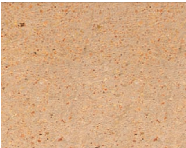
Bungalow: Untersicht des Vordaches mit bauzeitlichem „Konfetti-putz“
