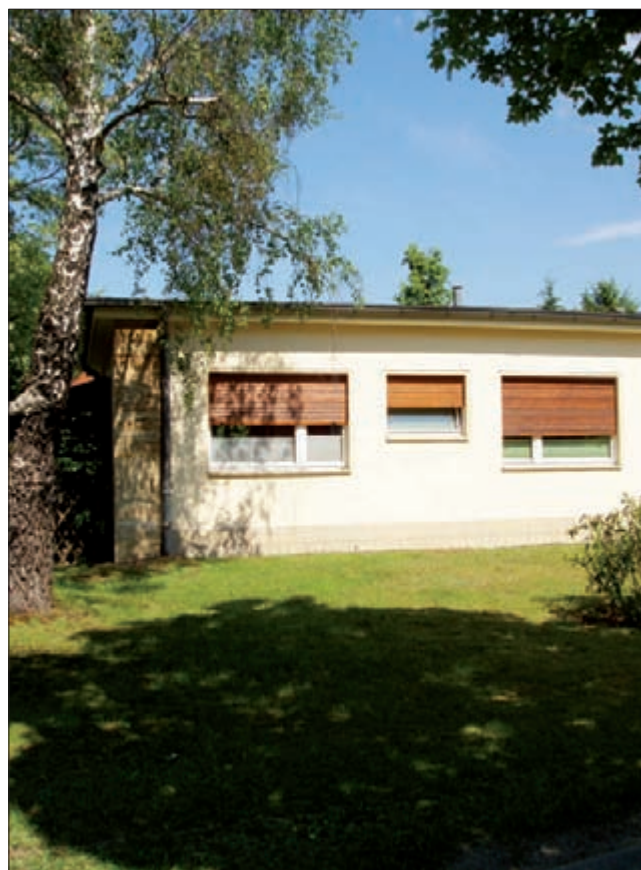
Bungalow: Bauzeitliche Fenster mit Rollläden
