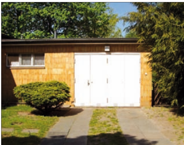
Bungalow: bauzeitliches Garagentor
