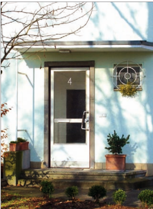
Duplex-Haus Typ B: Hauseingang
