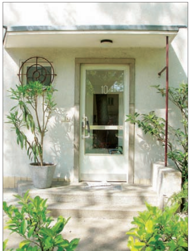
Duplex-Haus Typ B: Hauseingang mit Fenstergitter und Gestänge
