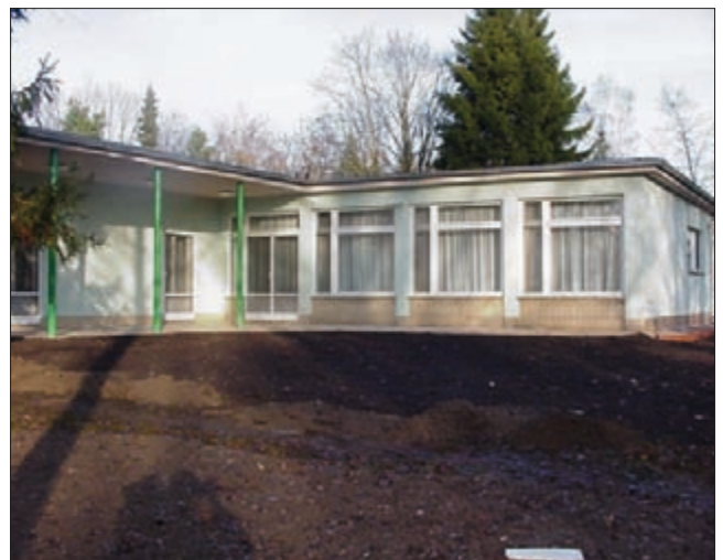
Bungalow: Rückfront nach Sanierung (vor Rasenaussaat)
