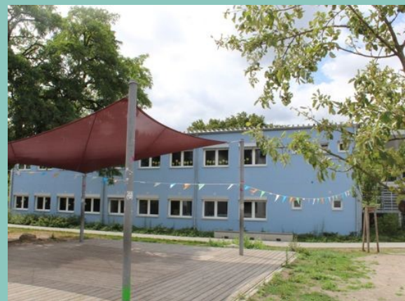
Containerbau der Giesensdorfer Grundschule
