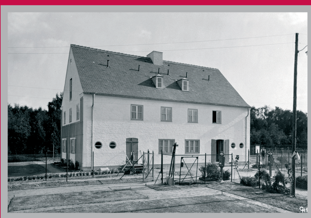
Doppelhaus von Paul Schmitthenner, Am Fischtal 66c/d, ca. 1930 Foto: © Bildarchiv Foto Marburg
