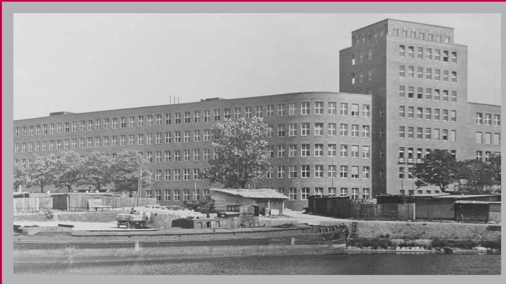
Das ab 1939 nach den Entwürfen von Paul Renner am Teltowkanal ausgebaute Loewe-Werk
