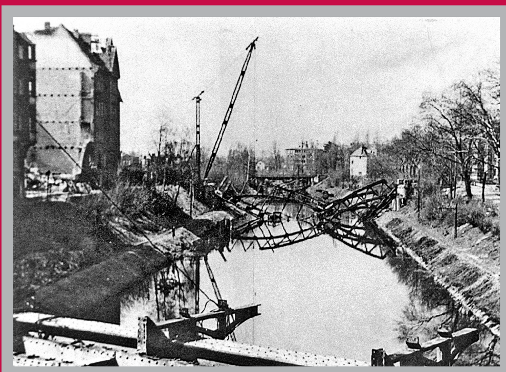
Die Siemens- und Hannemannbrücke bei Kriegsende.
