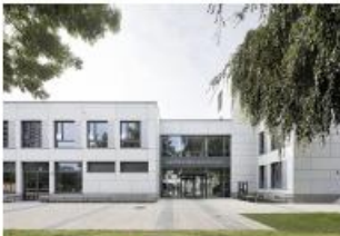
Abb. 7: Serielle Sanierung Marienfelder Grundschule
