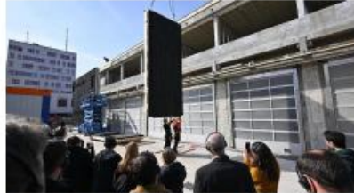
Abb. 8: Serielle Sanierung Feuerwache Charlottenburg-Nord
