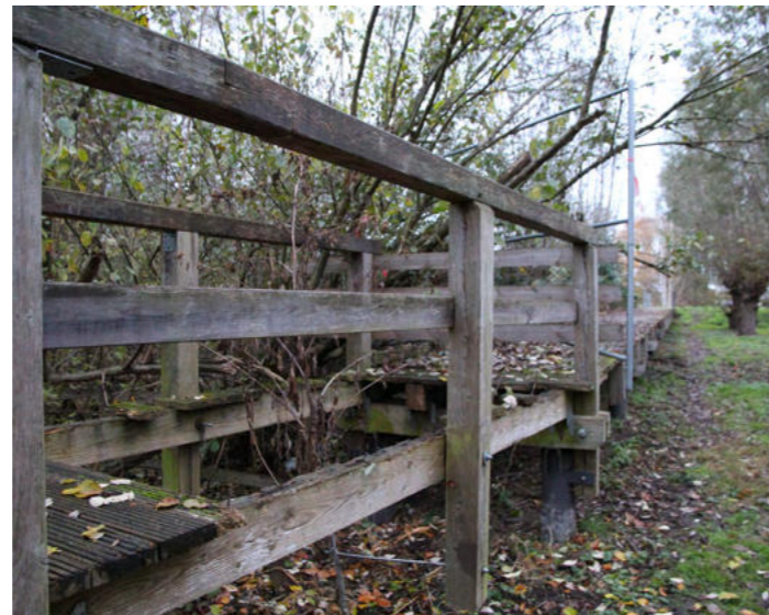
Aktueller Zustand der Steganlage am Egelpfuhlgraben Nord.
