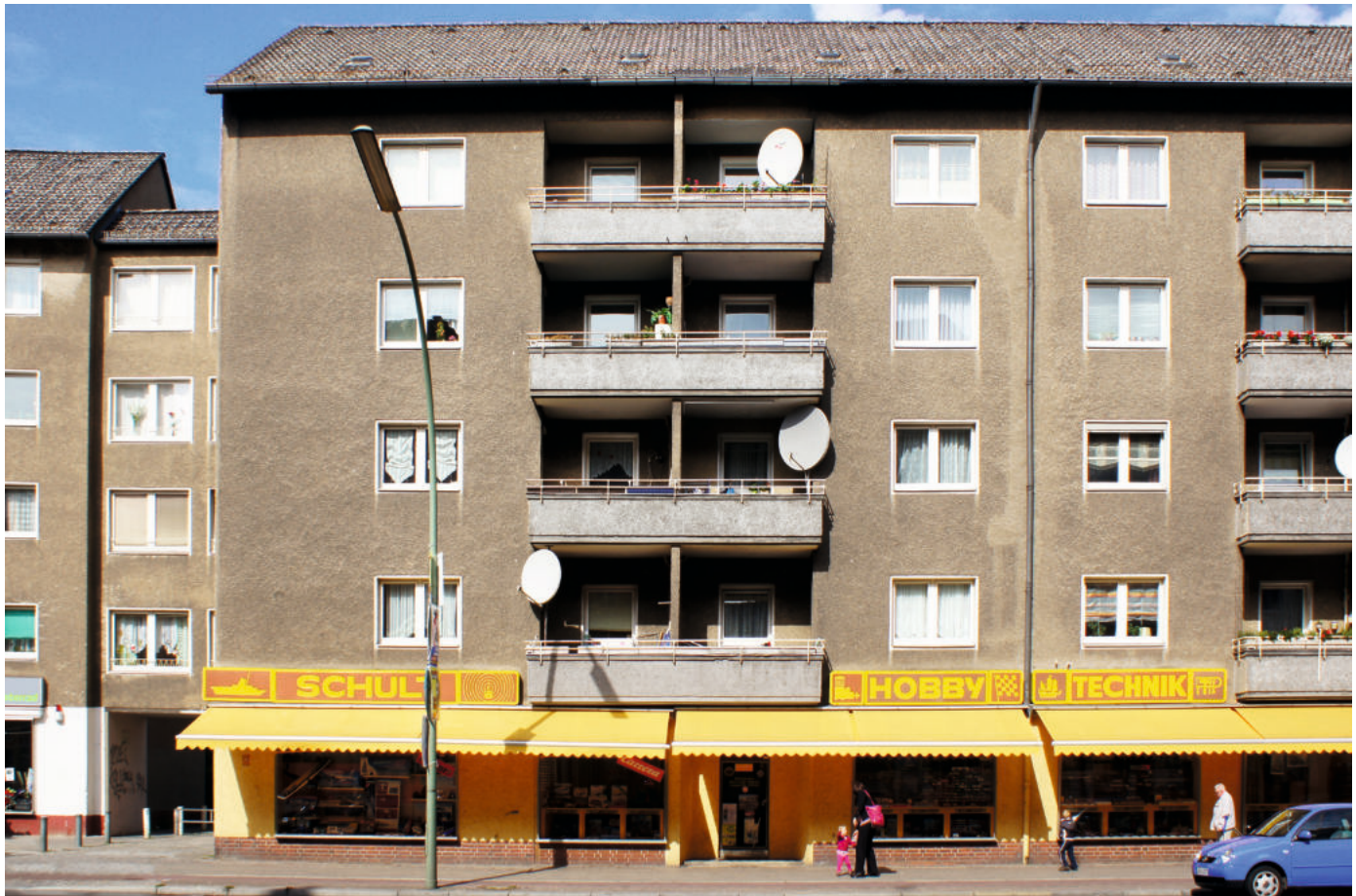
Siedlungsbau aus dem Wiederaufbauprogramm
