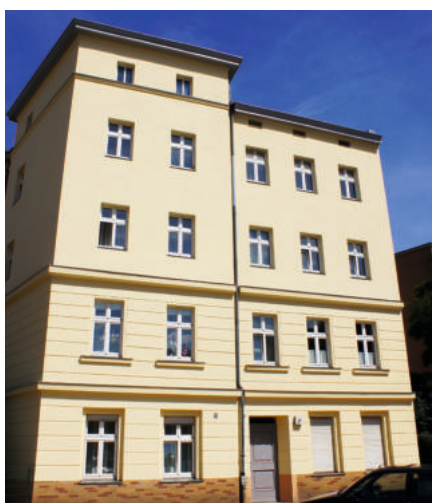
Durchgehende Fensterachsen vom EG bis unters Dach
