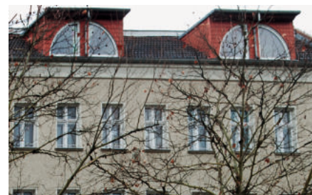
Gesimskasten als Bekrönung der Fassade
