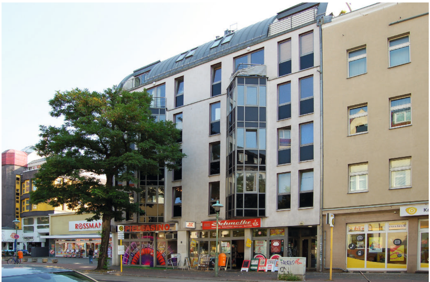
Ein seltenes Beispiel eines Tonnendachs mit entsprechendem Material
