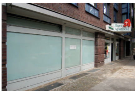
Deutlich abgesetzte Ladenzeile, Wandfläche aufgelöst
