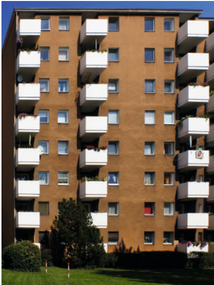
Baukastenprinzip; achtmal die gleiche Geschossgestaltung
