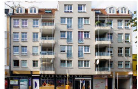
Anstelle der Wandscheibe wird hier die Frontseite des Erkers ins Dach hinein verlängert
