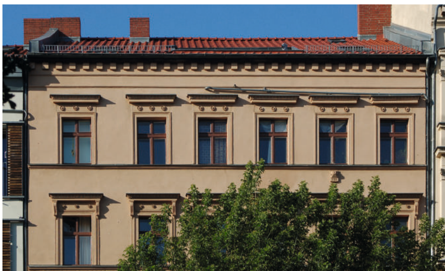
Dachausbau mit Belichtung über Terrassen und liegende Fenster
