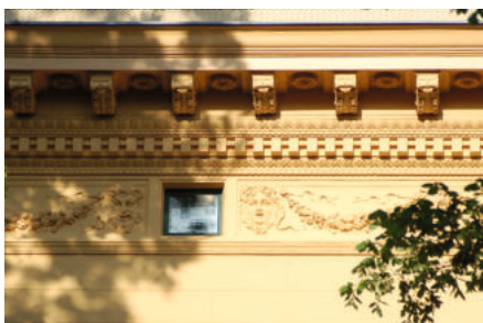
Optischer Abschluss der Fassade durch einen Gesimskasten
