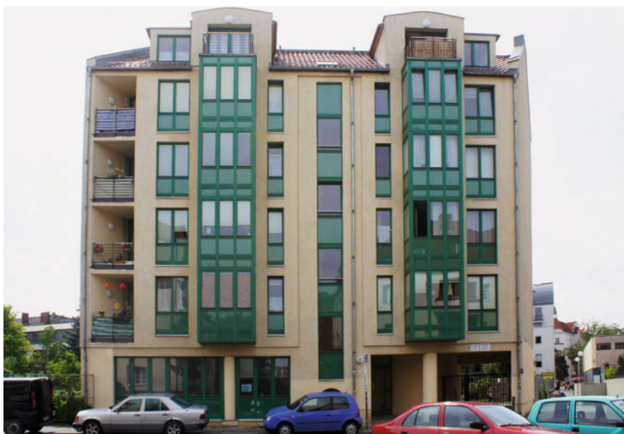
Durchgehende Trauflinie, Staffelgeschoss mit Flugdach
