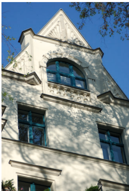
Mit dem Giebel ragt die Fassade in das Dach hinein
