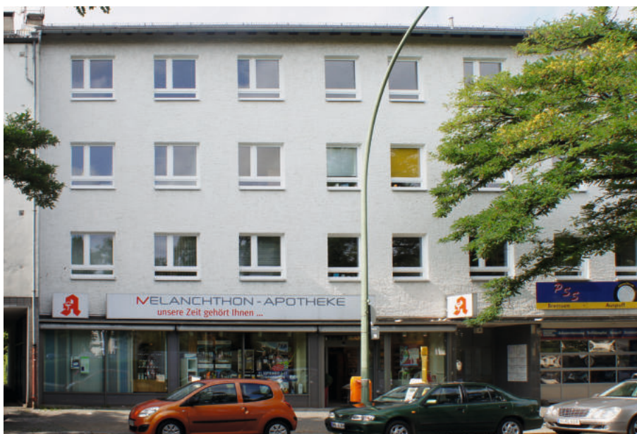
Flachdach und eigenständig gestaltete, betonte Ladenzone
