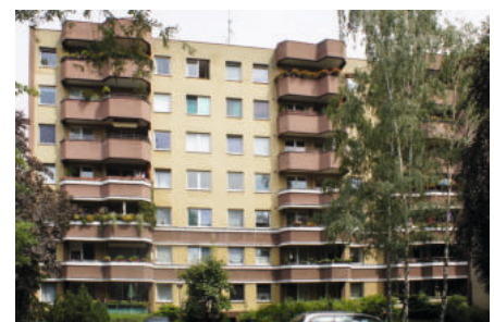
Zurückgesetztes Gebäude mit Vorgarten- fläche
