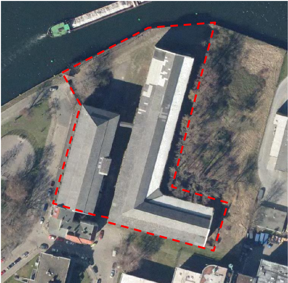
Abb. 1: UG mit Hallen der ehemaligen Geschützgießerei
