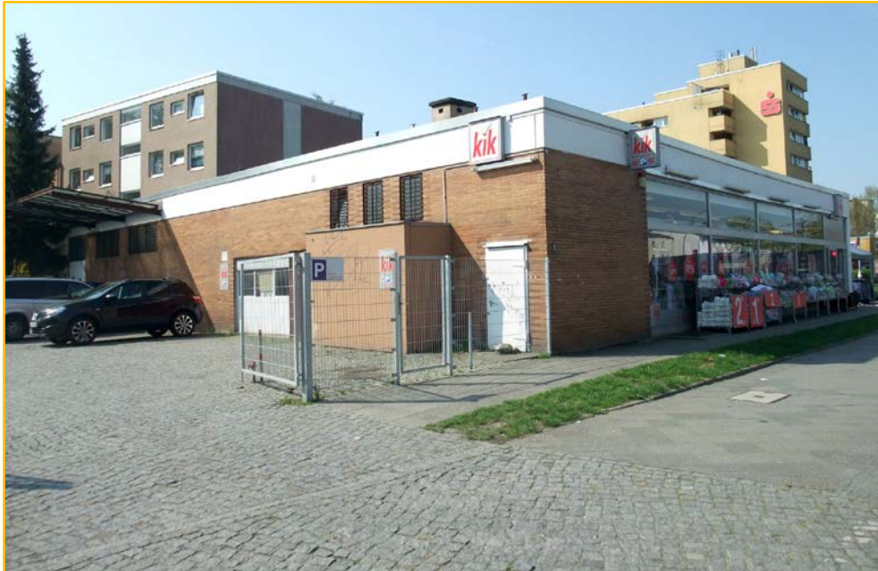
Brunsbütteler Damm 259: Das Grundstück ist nahezu vollständig versiegelt.
