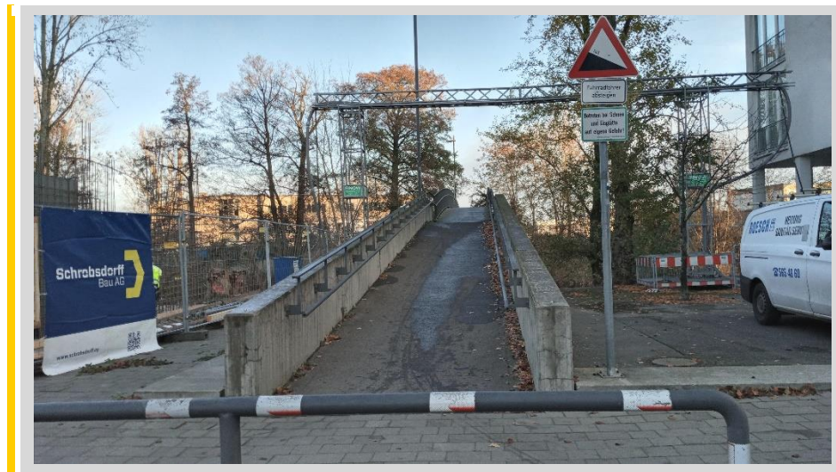
Abbildung 2.10: nördliche Fußgängerbrücke Maselakekanal
