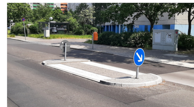
Querungshilfe in der Maulbeerallee ©Bezirksamt Spandau
