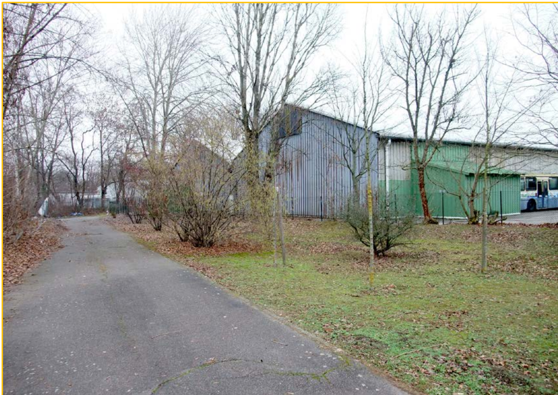
Nördliche Grenze des Untersuchungsgebiets Daumstr. 46-50 in Berlin-Haselhorst: Entlang des Erschließungsweges existieren in geringem Umfang unversiegelte Flächen.
