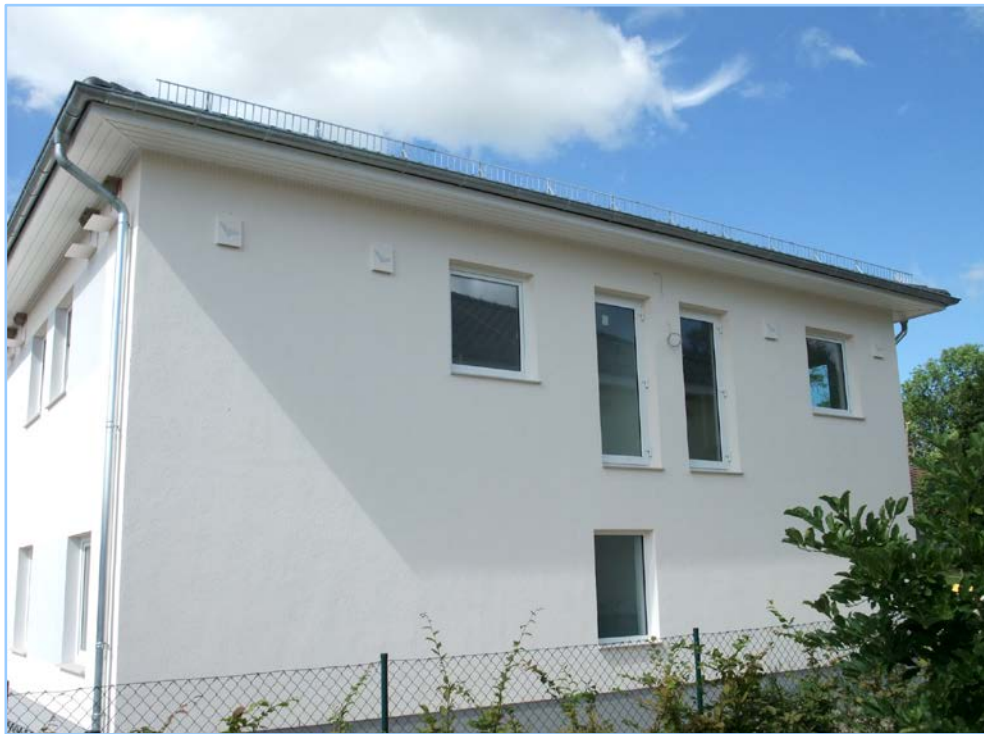
Anbringung von Ersatzquartieren (Fledermauswandschalen) an einem Sanierungsobjekt in Schwante, Dorfstraße 28.
