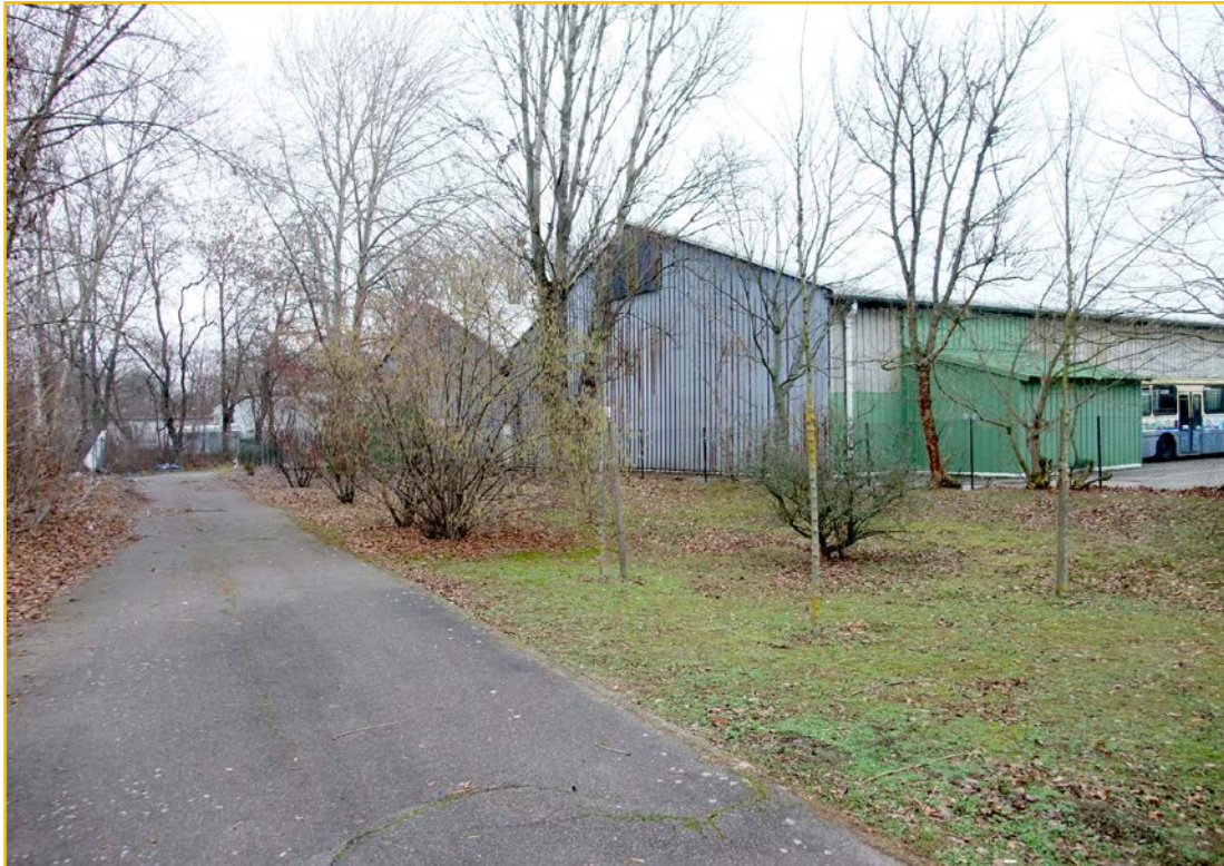
Nördliche Grenze des Untersuchungsgebiets Daumstr. 46-50 in Berlin-Haselhorst: Entlang des Erschließungsweges existieren in geringem Umfang unversiegelte Flächen.
