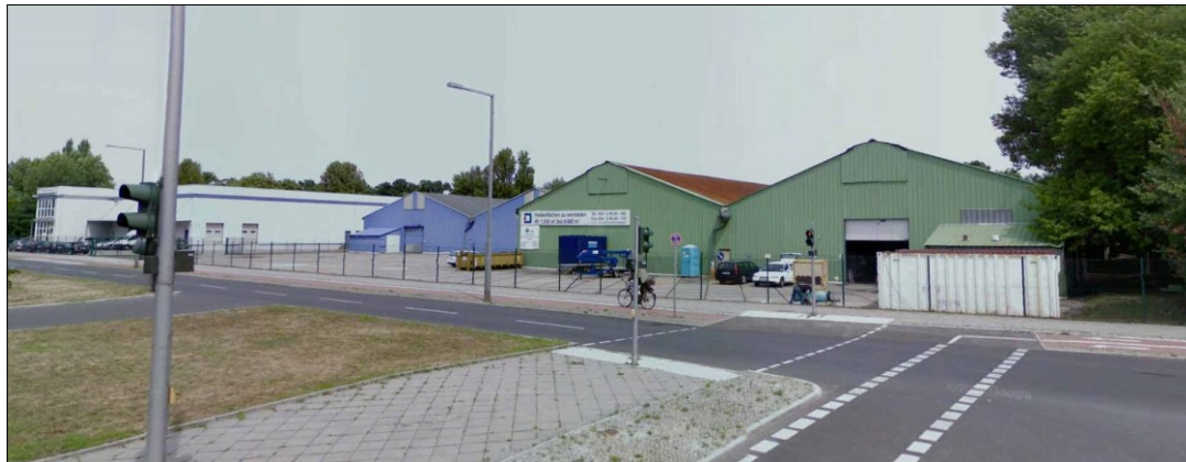
Abb. 7: Straßenansicht Daumstraße 46 und 50
