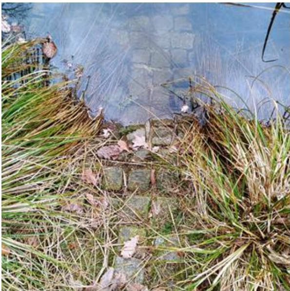
Abb. 3: Pflastersteine am Rand des Ersatzlaichbiotops dienen der Beurteilung des Wasserstandes
