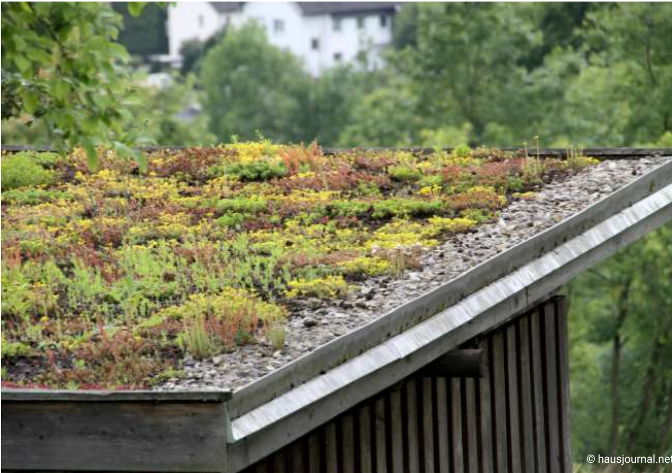
Begrünung von Mülltonnenstellflächen etc.
