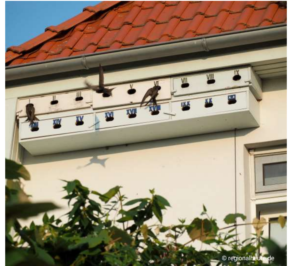
Bei Fassadensanierung – Nistkästen anbringen
