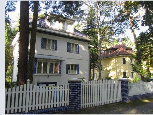
Zweite Bauphase; Zwischenkriegszeit Dinkelsbühler Steig 16/18
