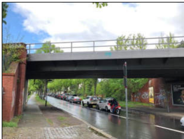
Abbildung 12: Eisenbahnüberführung Hermsdorfer Straße (Blickrichtung Norden)
