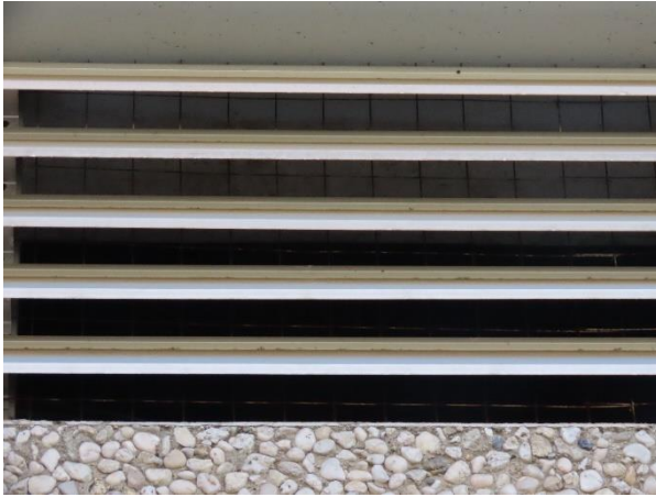
Abb. 17: Gitter hinter den Lamellen am Parkhaus
