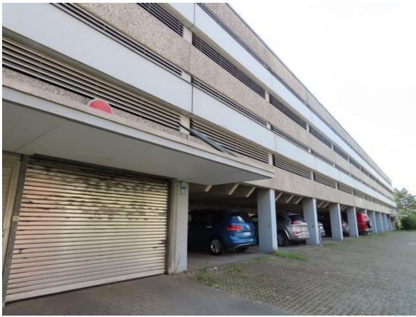
Abb. 4: Parkhaus entlang der Rue Georges Valle- rey
