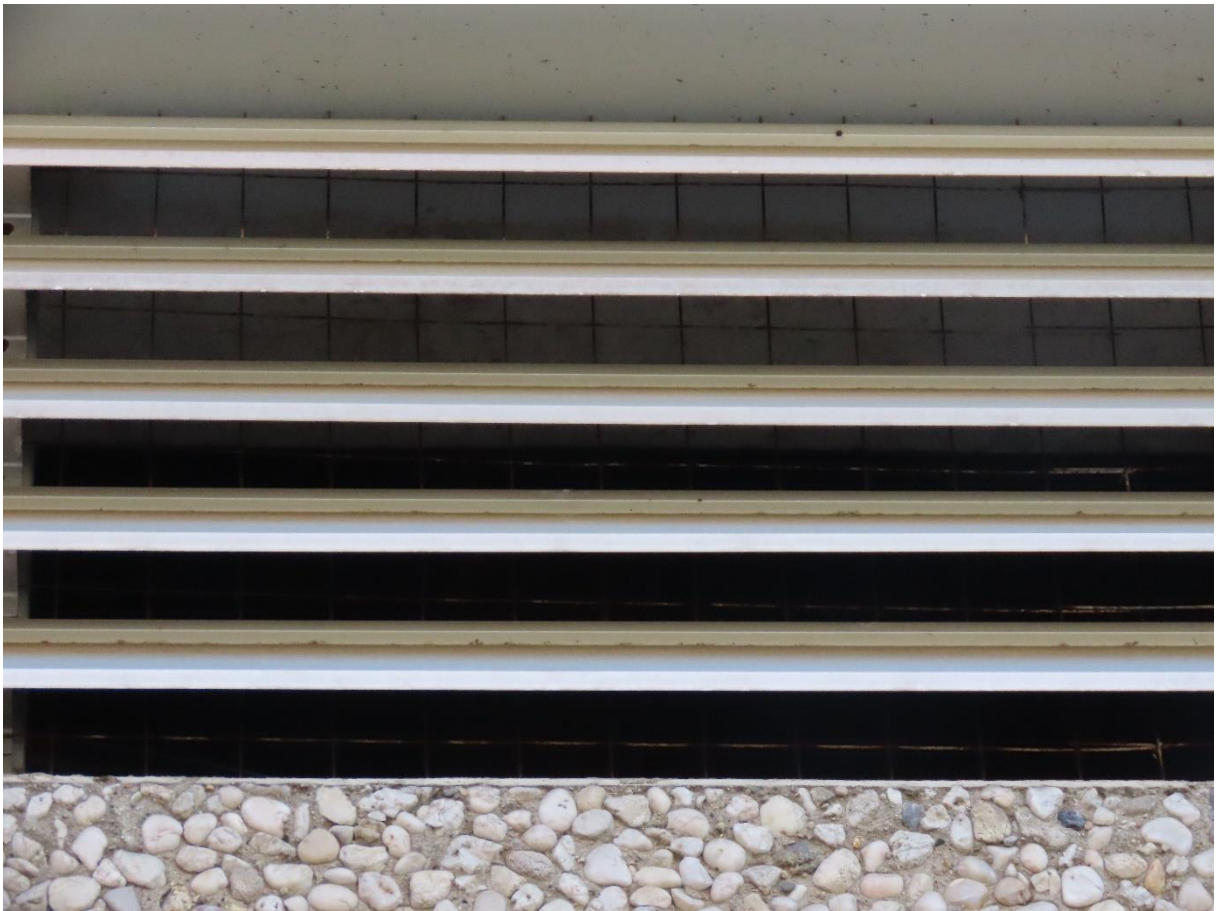
Abb. 10: Gitter hinter den Lamellen am Parkhaus
