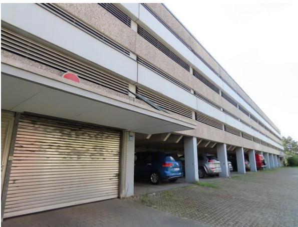
Abb. 4: Parkhaus entlang der Rue Georges Valley
