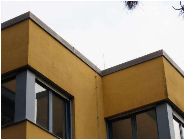
Abb. 31: Fugen hinter Dachkantenblechen an Bestandsgebäuden
