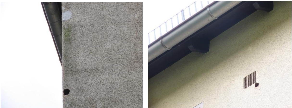
Abb. 36 u. 37: In der Wärmedämmung vorhandenen Niststätten
