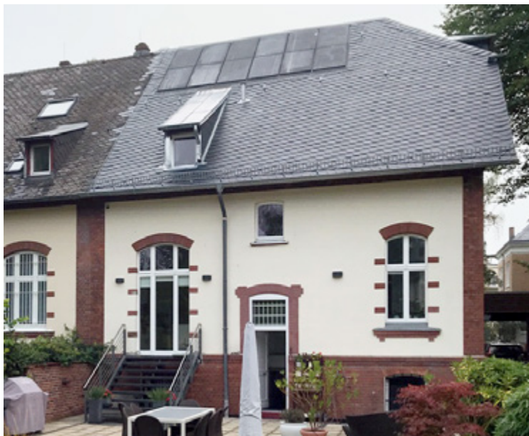
Abbildung 49 Farblich angepasste PV-Anlage auf einem Denkmal.
