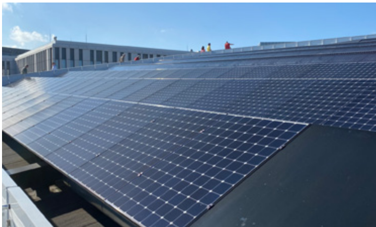
Abbildung 12 Monokristalline Module.
