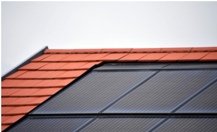
Abbildung 25 Indach-PV-Anlage.
