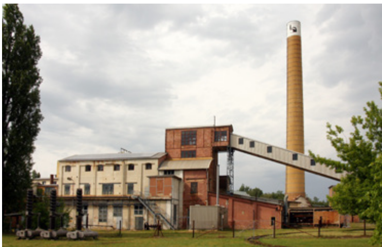
Abbildung 37 Denkmal Brikettfabrik Louise mit PV-Anlage, Dohmsdorf.
