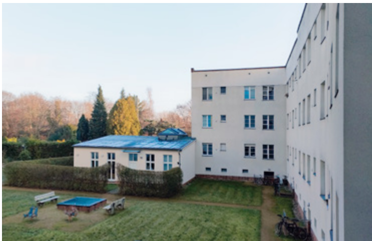
Abbildung 51 Das Dach eines denkmalge- schützten Waschhauses ist aus dem halböffentlichen Raum einsehbar, entfaltet jedoch nur eine untergeordnete städte- bauliche Wirkung. Die visuelle Beeinträchtigung konnte durch die PV-Anlage mit den sehr flachen Modulen reduziert werden, der Zeugniswert des Gebäudes bleibt gegeben.
