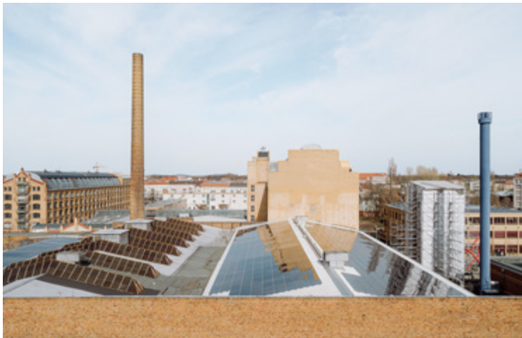
Abbildung 36 PV-Anlagen auf denkmalgeschützten ehemaligen Fabrikgebäuden.
