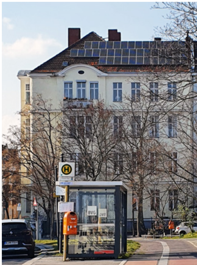
Abbildung 5 Eine PV-Anlage, die die Kleinteiligkeit und Geometrie des Dachs kaum berücksichtigt und somit die architektonische und städtebauliche Wirkung des Gebäudes beeinträchtigt.
