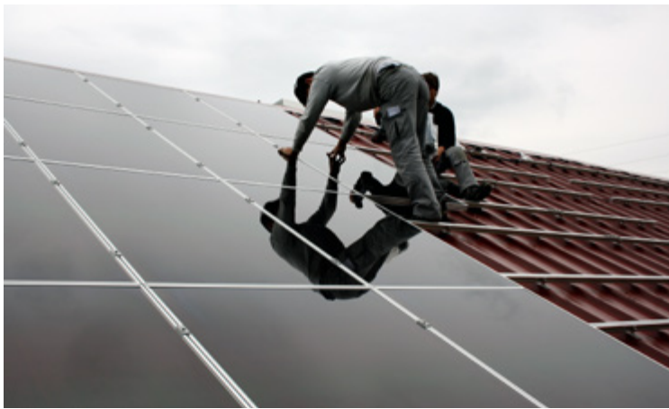
Abbildung 13 Dünnschichtmodule.
