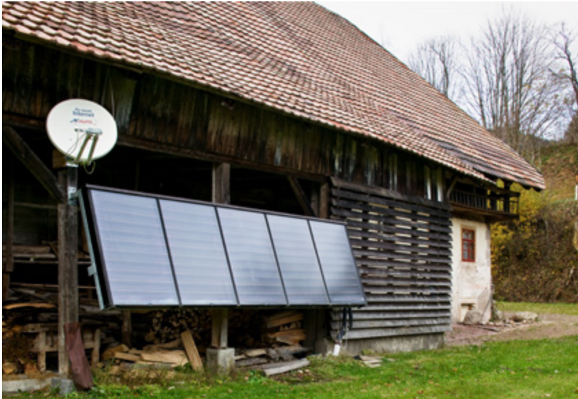
Abbildung 60 Solarthermische Anlage.
