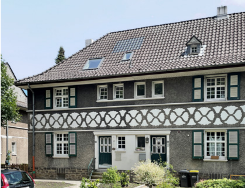
Abbildung 61 PV-T-Dachpfannen in einer denkmalgeschützten Siedlung.
