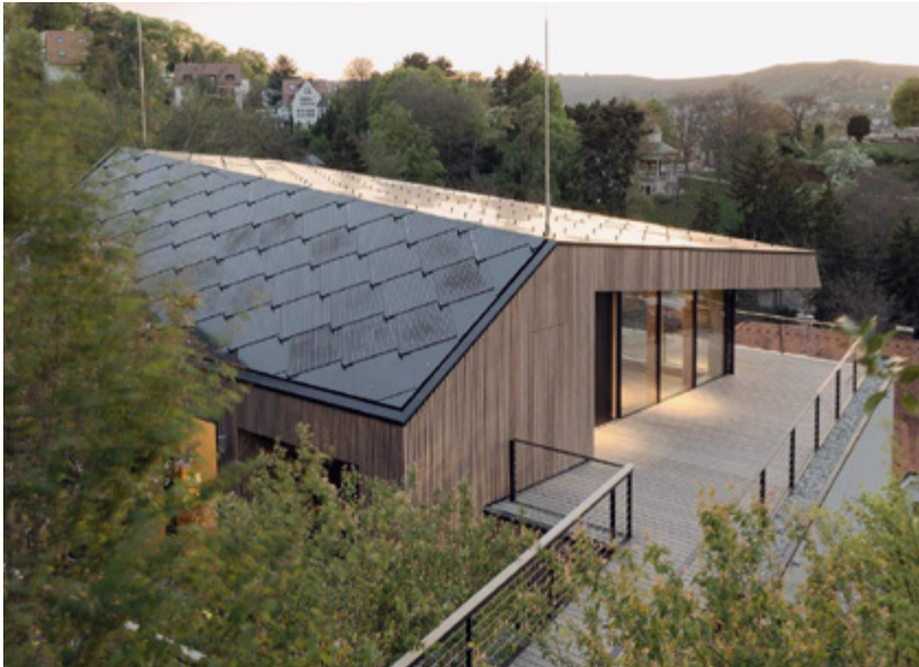
Abbildung 20 Bauwerkintegrierte Photovoltaik- schindeln.
