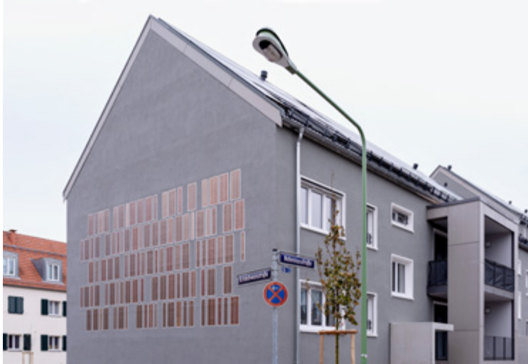
Abbildung 56 Gestaltete Photovoltaikanlage an einer Brandwand.
