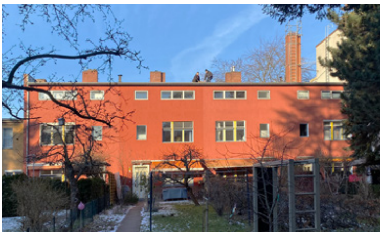
Abbildung 58 Bemusterung einer PV-Anlage in Welterbesiedlung.
