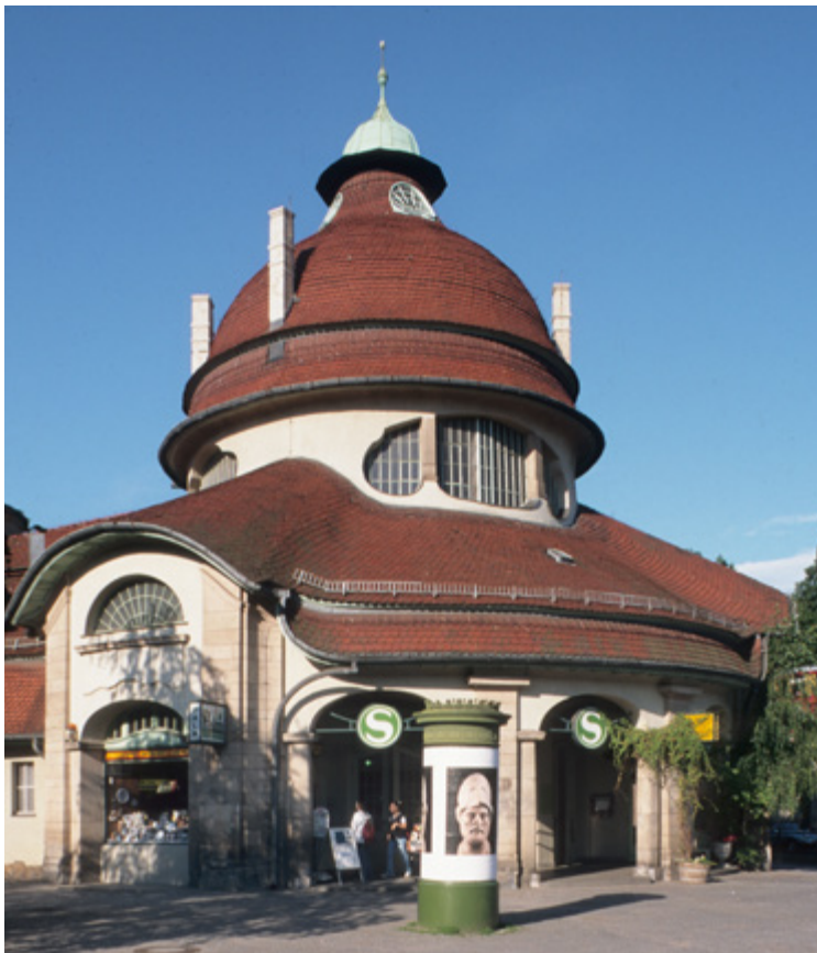
Abbildung 45 Aufwendig ausgebildetes Dach des S-Bahnhofs Mexikoplatz.
