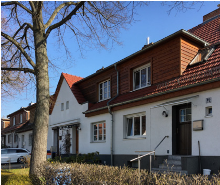
Abbildung 59 Dachflächen in einer denkmalgeschützten Gesamtanlage.
