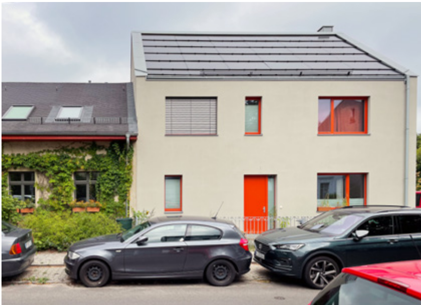
Abbildung 40 Dachintegrierte PV-Anlage auf Neubau neben einem Denkmal.
