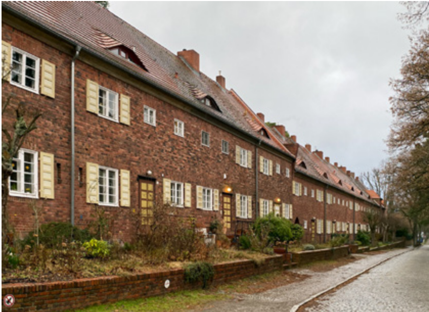
Abbildung 3 Homogene Dächer einer denkmalgeschützten Siedlung.
