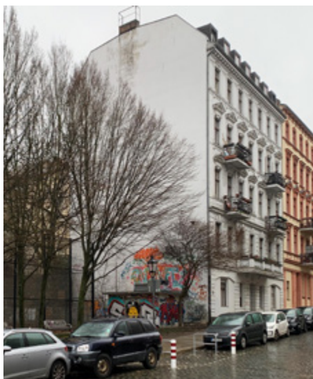
Abbildung 39 Brandwand in einem Denkmalbereich.
