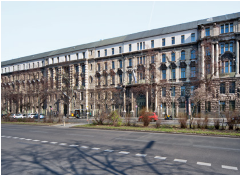
Abbildung 38 Denkmal mit überformtem, nicht bauzeittypischem Dach.
