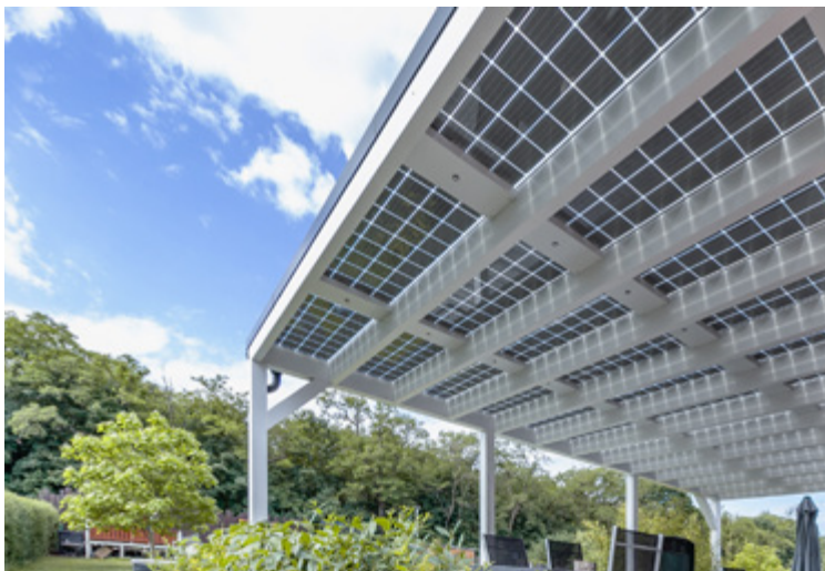
Abbildung 16 Semitransparente Module.
