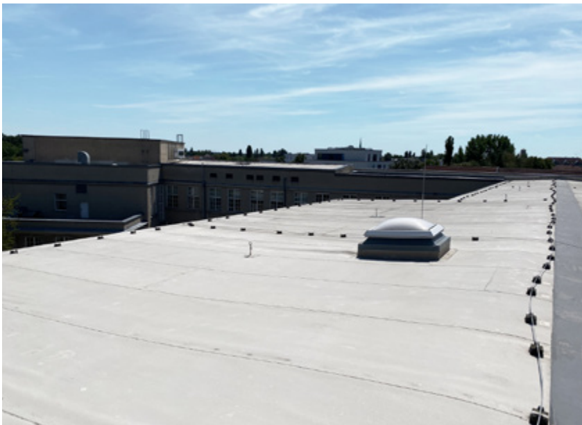
Abbildung 32 Flachdach der Hochschule für Technik und Wirtschaft Berlin.
