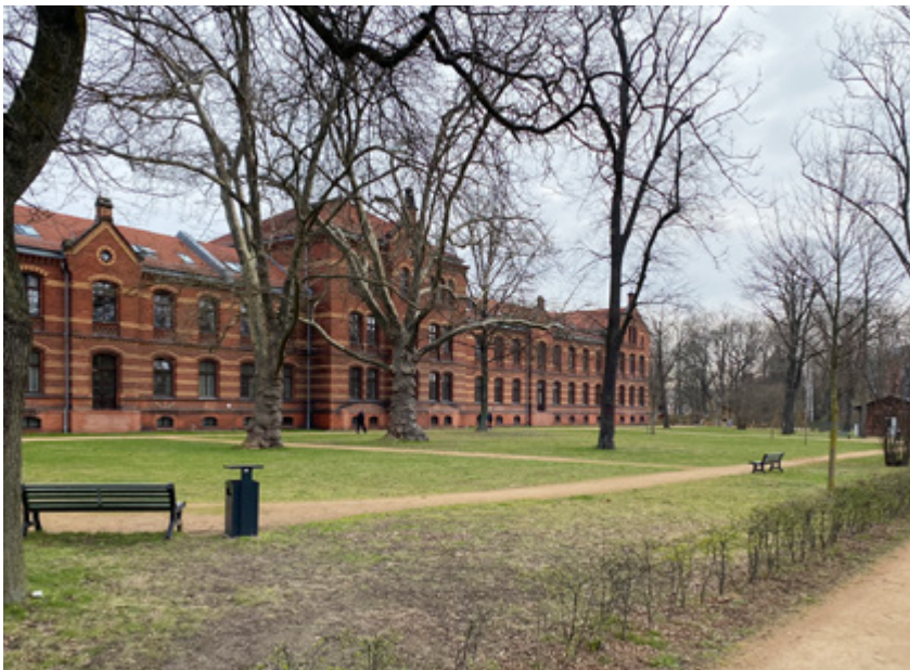
Abbildung 35 Nur aus dem halböffentlichen Raum eines Krankenhausgeländes einsehbare Dachflächen.
