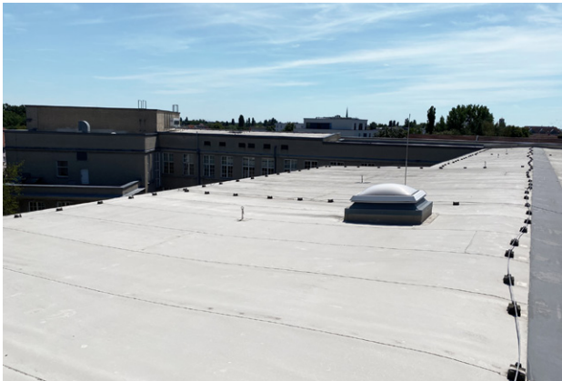
Abb. 1: Flachdach der Hochschule für Technik und Wirtschaft
