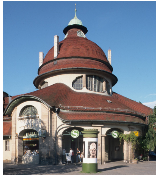
Abb. 18: Aufwändig ausgebildetes Dach des S-Bahnhofs Mexikoplatz
