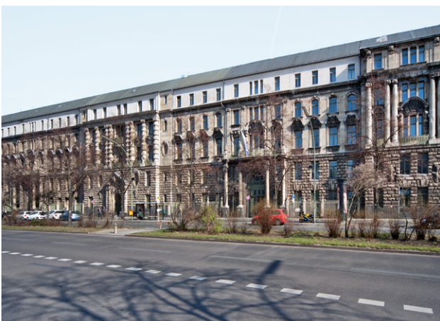
Abb. 6: Denkmal mit überformtem, nicht bauzeitlichem Dach
