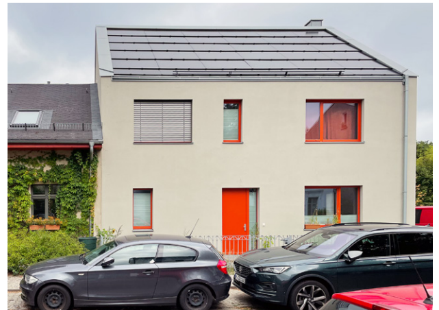
Abb. 8: Dachintegrierte PV-Anlage auf Neubau neben einem Denkmal
