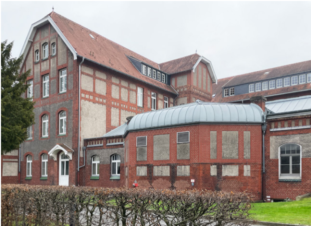
Abb. 4: Die Dachfläche ist nur vom halböffentlichen Bereich aus zu sehen
