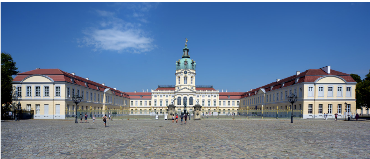
Abb. 17: Dachflächen der weithin sichtbaren Schlossanlage Charlottenburg
