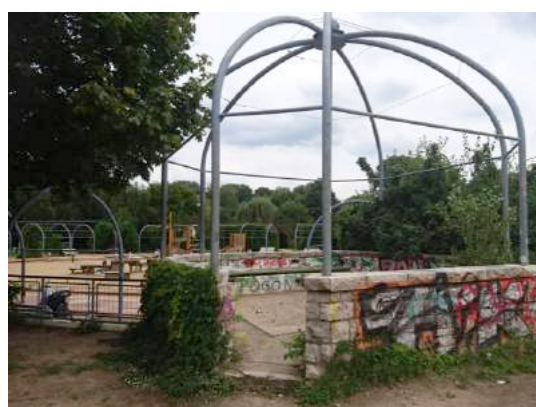
Treffpunkt, Balkon an der Straße „Am Bürgerpark“
