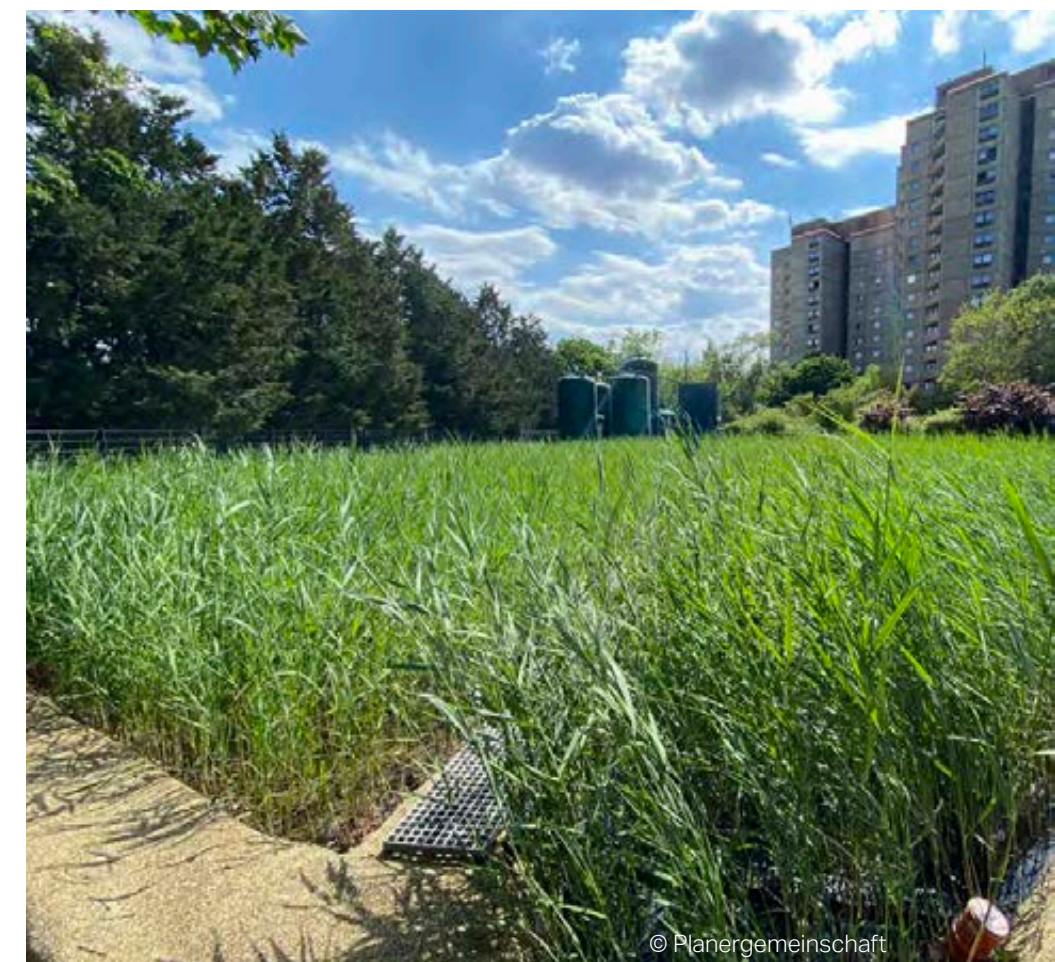
Der bewachsene Bodenfilter der Pflanzenkläranlage
