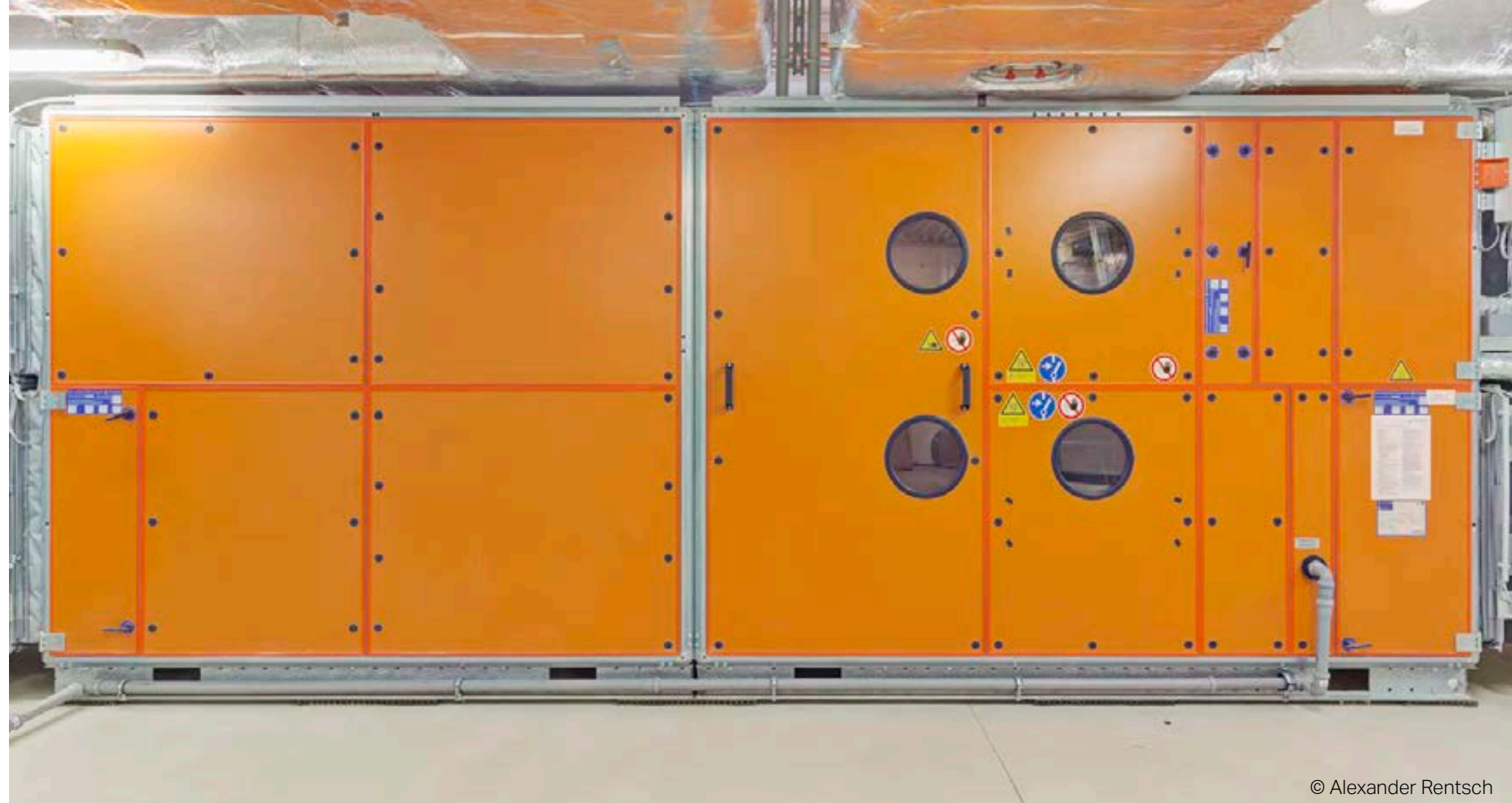
Heizungsanlage (Blockheizkraftwerk)
