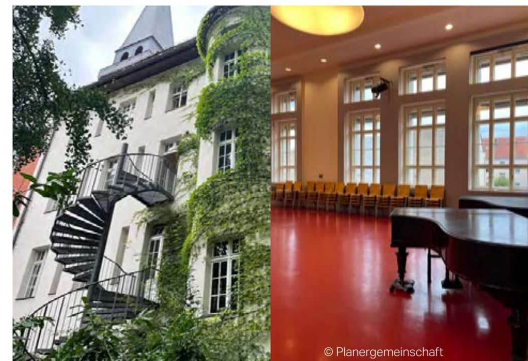
links: Neue äußere Fluchttreppe, rechts: Sanierte Aula
