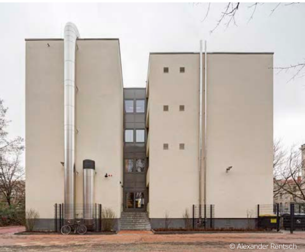
Außenansicht der zentralen Lüftungs- und Heizanlage
