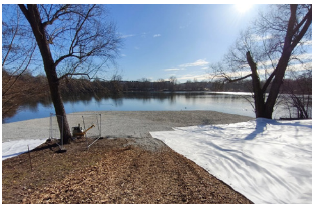
Aufschüttung für die neue Aussichtsplattform am Nordufer
