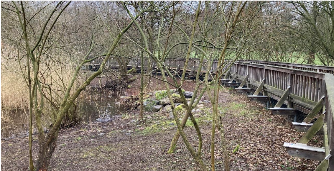
Abbildung 4: Einlaufbauwerk und Uferrandbereich Rixdorfer Teich, Frühjahr 2024
